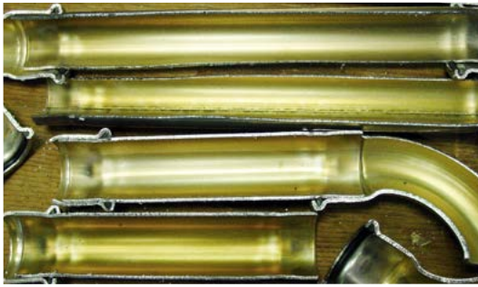
Bild 6: Teile des geprüften Systems nach Versuchsende
