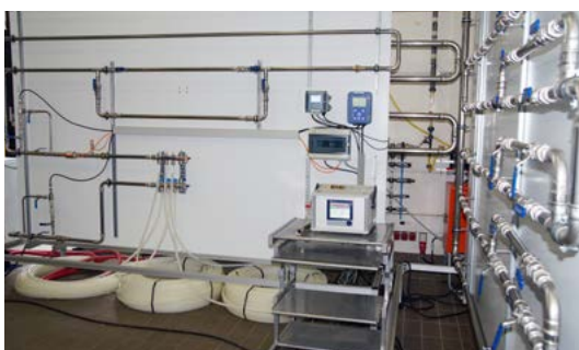
Bild 3: Prüfstand IWW mit Rohrleitungen und Messtechnik
